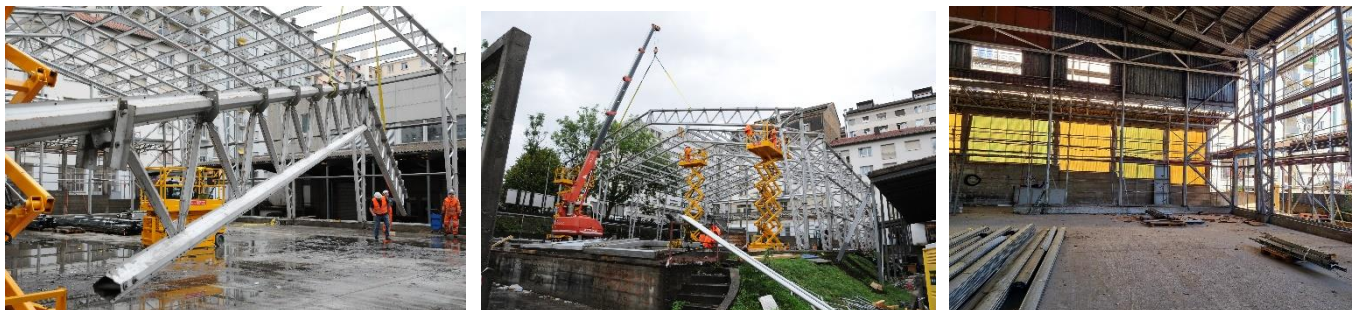
Figure 1 : Photographies prises durant le démontage de la halle POLYNORM
